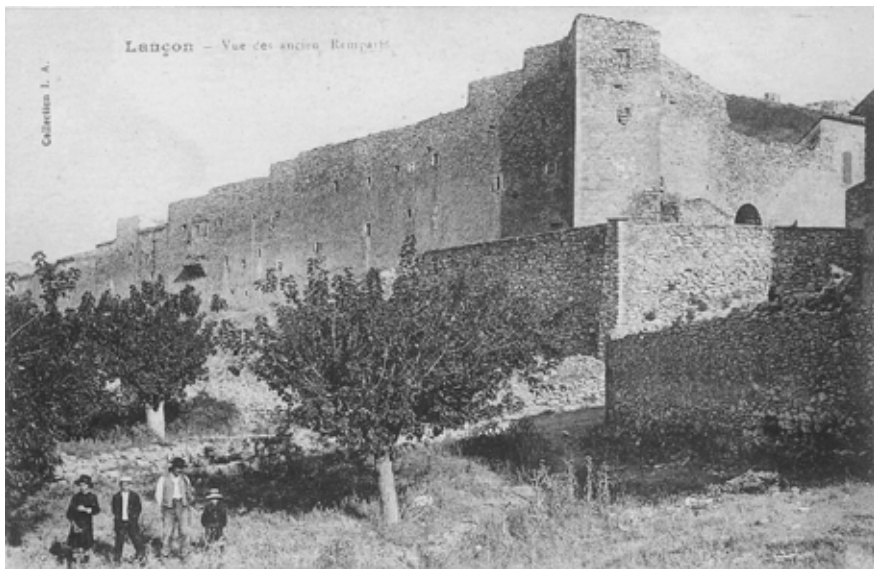
Fig. 7 - Au début du XXe siècle, traces de voûte et toiture sur le rempart, entre la tour et la porte de la glacière.
